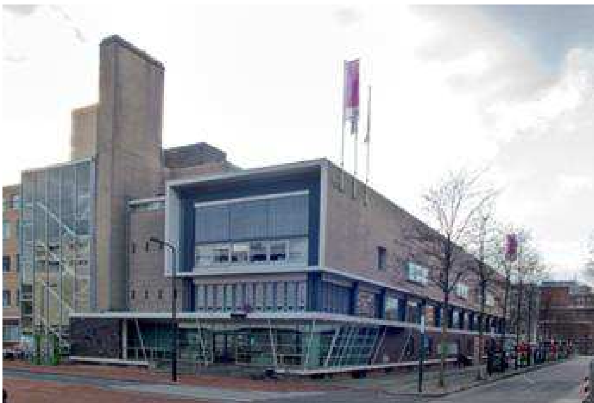
Afbeelding 4.2: Foto van het bestaande gebouw, het voormalige postkantoor
