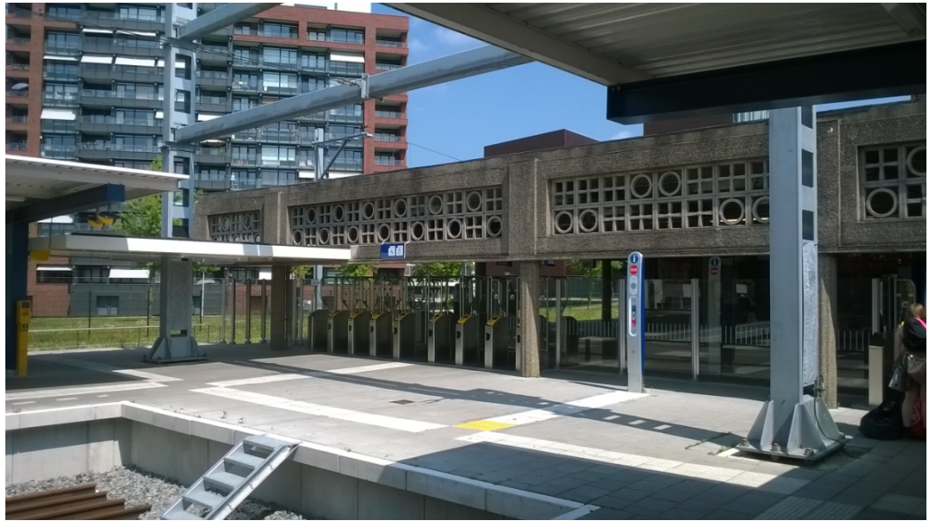
Zicht op OVCP en dakconstructie stationsgebouw, links bevindt zich perron 4
