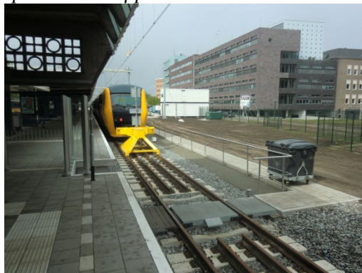
Spoor 4a met afscherming t.b.v. OVCP
