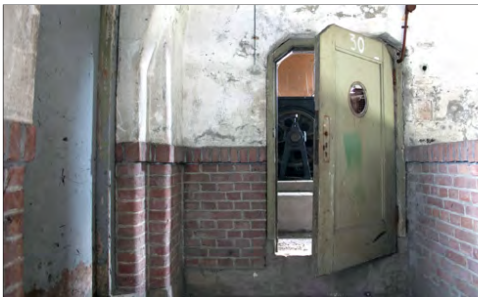
▲ Deur naar de liftkamer.
