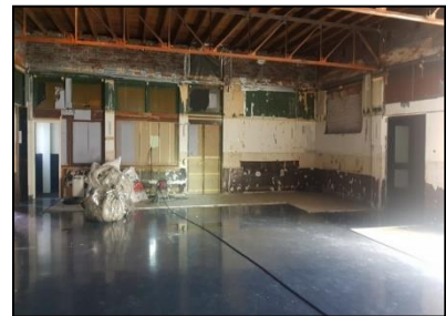
Figuur 5. Voormalige dansvloer.
