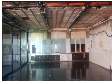
Figuur 4. Binnenzijde van de onderzoekslocatie.
