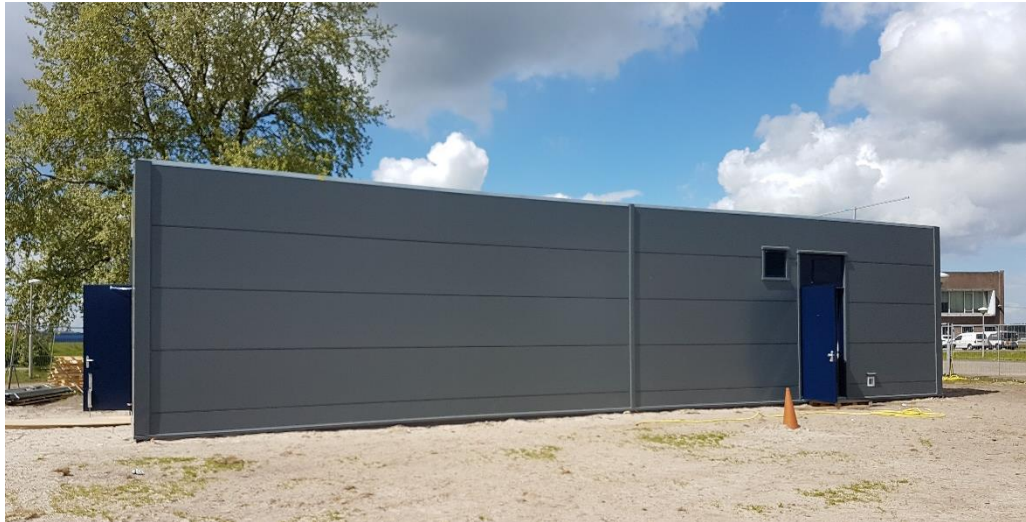
Figuur 4.1 Voorbeeld modulair gebouw
