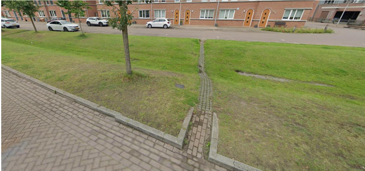
Figuur 9: Impressie van afvoer water van de weg naar wadi (bron: Google)
